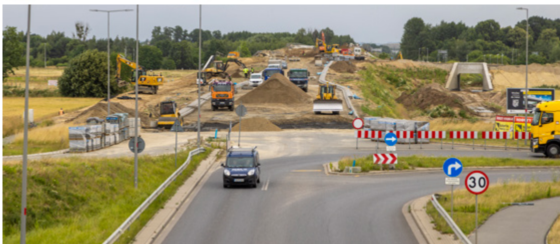
Widok na fragment al. 11 Listopada prowadzącej na nowo budowany wiadukt nad torami
